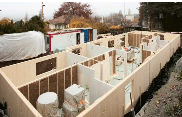
Schweizweit erster Keller aus Holz am Blümlimattweg 15 in Thun. Bild zVg. Timbatec AG
