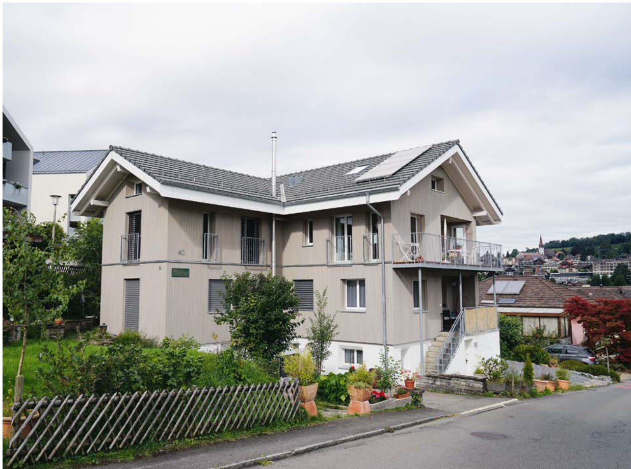
Mit Schweizer Holz ausgeführte Aufstockung eines Einfamilienhauses in Spiez.
