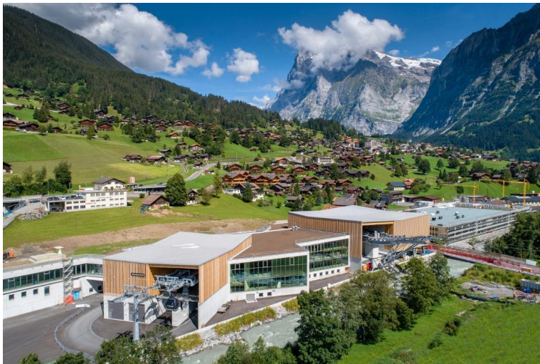
Bild 1: Terminal Grindelwald Grund
