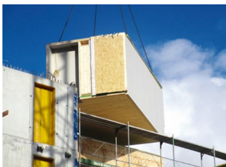
Modulbau in Adelboden, Bild Martin Rösti.
